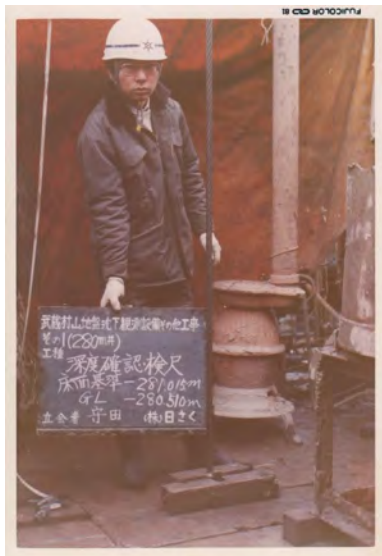
観測井戸掘削工事・深さ確認
