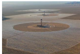
米国加州・モハーベ砂漠のイバンパ太陽発電所：世界最大級392MWの集光型太陽熱発電所、7m 2 の鏡X35万枚(2013) 出典：米NRG Energy
