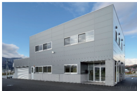
地下水循環型地中採放熱システム:Heat-Gw-Power® 導入事務所ビル(鉄骨造 2 階建、延べ床面積 370.3m 2 )
