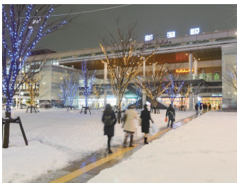
地中熱ヒートパイプ歩道融雪状況
