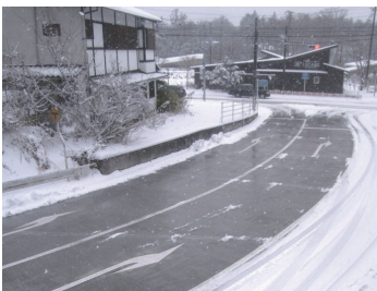
地中熱ヒートパイプ車道融雪状況
