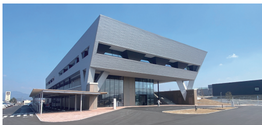
庁舎の空調導入事例
