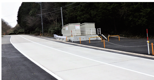
融雪調査設計、及び熱交換井工事等実績 (主要地方道玉湯吾妻山線佐白工区)
