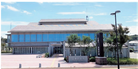
県内の公共施設として初めて地中熱空調熱交換井工事実績 (江津市役所新庁舎)
