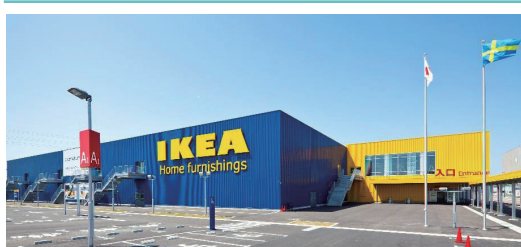
商業施設の空調導入事例
