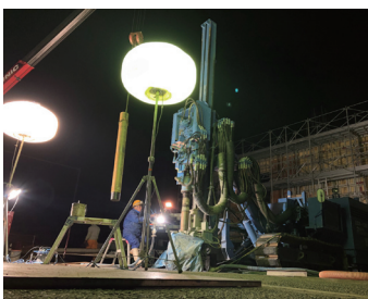
SAGAサンライズパーク 地中熱交換井掘削工事
