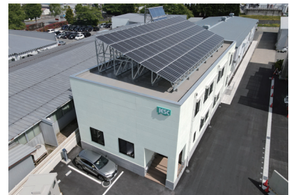
高効率帯水層蓄熱冷暖房システム （JESC-ZEB棟）
