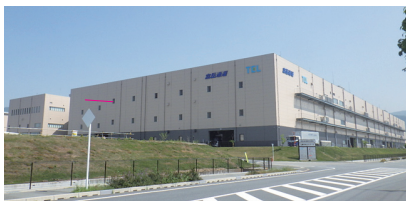
ロジパーク山梨中央 / 空調
