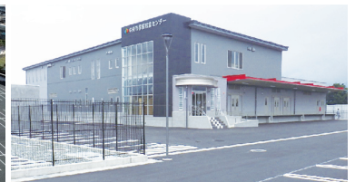
中央市学校給食センター / 給湯
