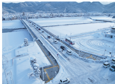
無散水融雪システム （山形市馬見ヶ崎橋歩道）
