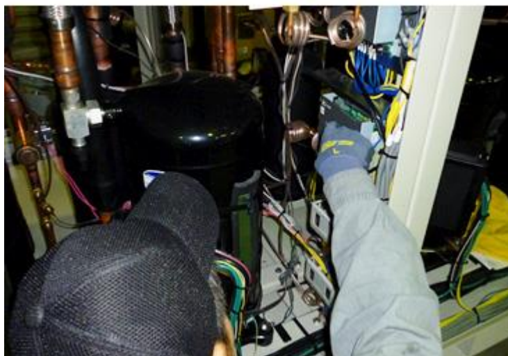
保護センサーの動作確認
