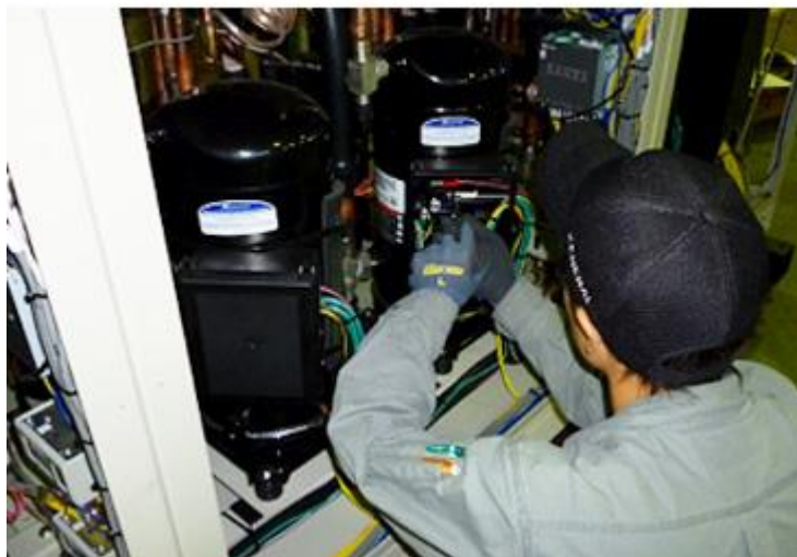
保護センサーの動作確認
