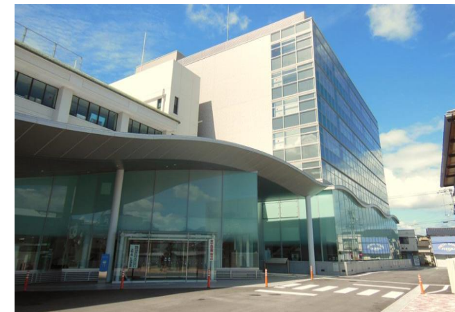
災害時に近隣住民の一時避難場所となる1階ロビー(900m 2 )に地中熱ヒートポンプによる空調を導入。
