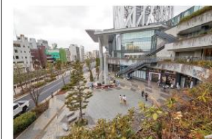
東京スカイツリータウン ソラマリアの地中熱(深さ約120m)でチューブが敷設されている。
