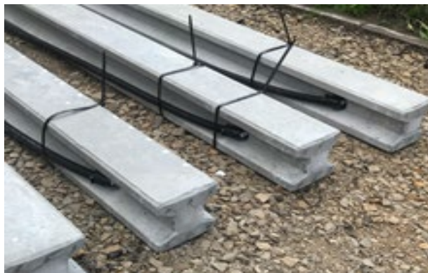
地中熱交換器を取り付けたH型PC杭
