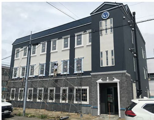
ZEB化実証建物（地中熱ヒートポンプシステム、高断熱仕様外皮、放射空調システム、太陽光発電）
