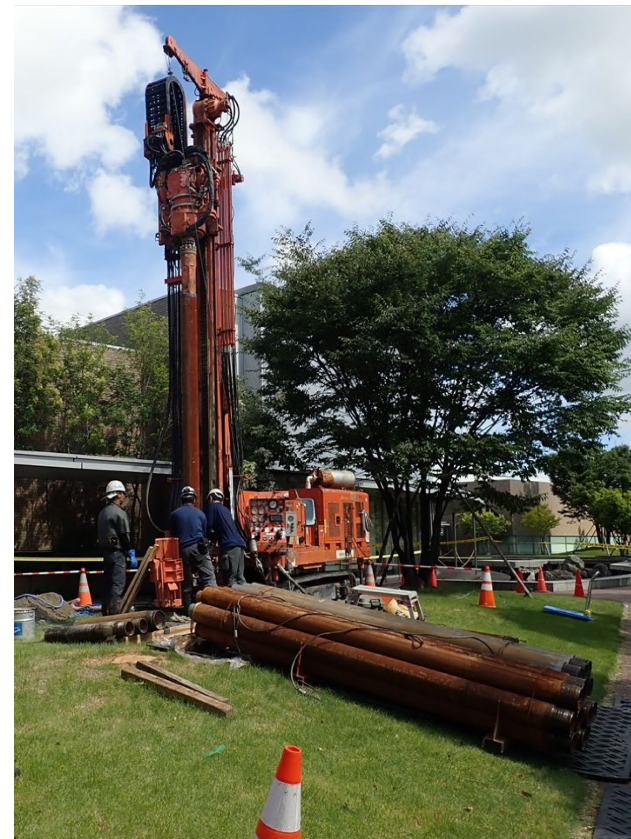
地中熱交換井の掘削
