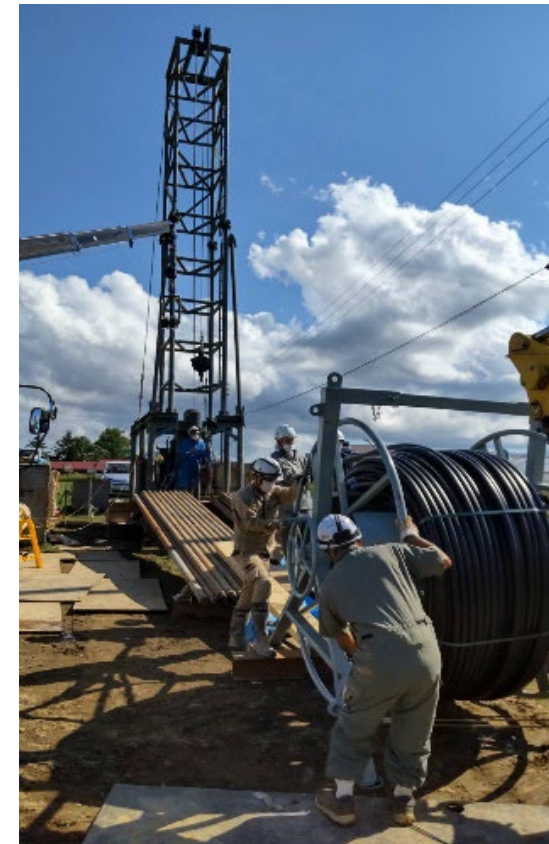
深度300m孔井のUチューブ施工
