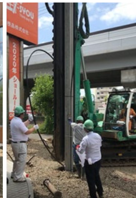
基礎杭兼用地中熱交換器の施工試験
