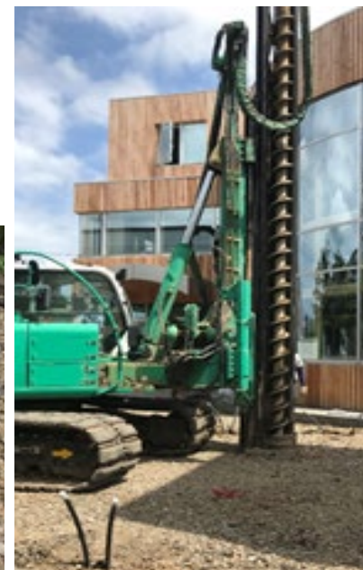
基礎杭兼用地中熱交換器の施工試験
