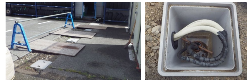
直膨式地中熱交換器の施工
