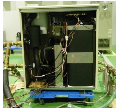
地中熱ヒートポンプ給湯器 (CO2冷媒使用)
