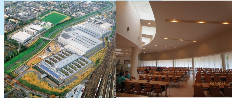
実証建物外観（左）と内観（右） （株）豊田自動織機大府工場
