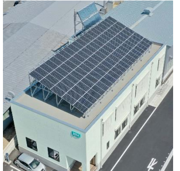
ZEB仕様実証建物→
