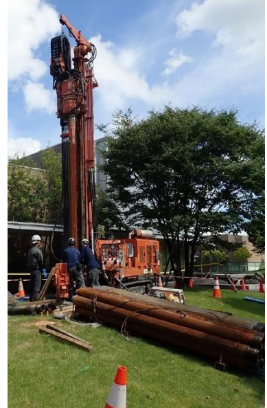
地中熱交換井の掘削 12
