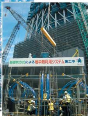
基礎杭方式 施工：大成建設
