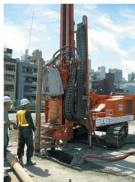
ポアホール方式 施工：大林組(三菱マテリアルテクノ)
