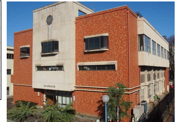
[施設外観] 建物1階が空調対象の公民館、2・3階は体育館。長良川扇状地に位置し、地下水温は夏季に低下、冬季に上昇する。
