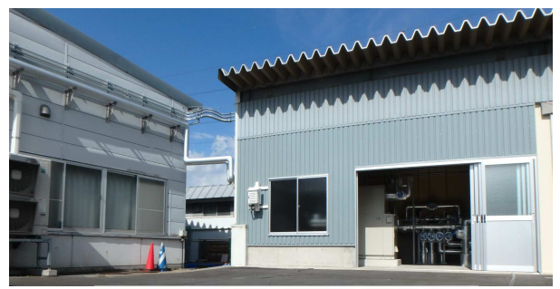
左: 冷暖房対象施設(180㎡)、右: 機器室 [施設外観]
