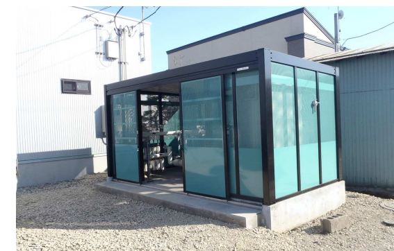
動力計装盤、ヘッダーを収納 [地中熱機械室]
