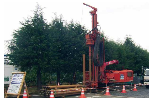
[ソニックドリルによる井戸掘削]
