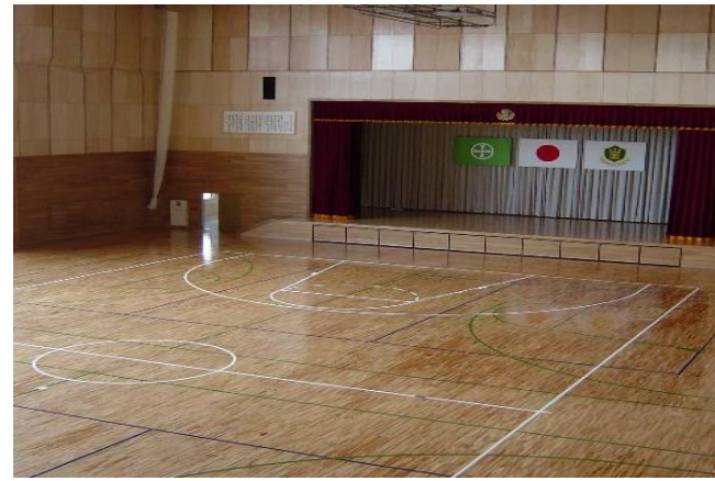
体育館全床面積1,036㎡のうち970㎡の床暖房を担う。
