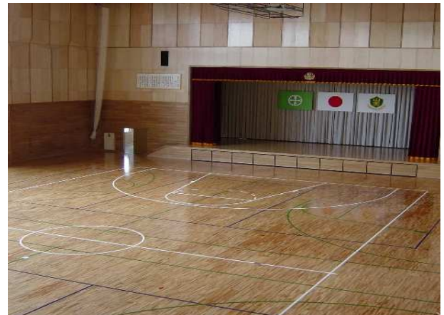
体育館全床面積1,036㎡のうち970㎡の床暖房を担う。
