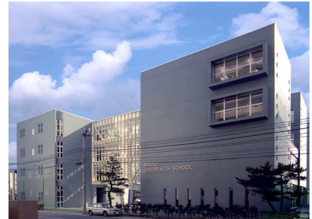
山王中学校正面風景。基礎杭方式による地中熱利用システムを採用。
