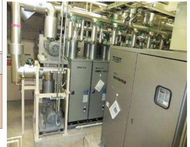
既設の機械室において、熱源機の入替えが行われた。
