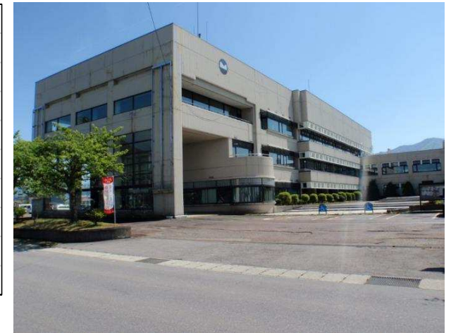
既存の役場庁舎において、空調機器の更新工事で地中熱ヒートポンプシステムが導入された。
