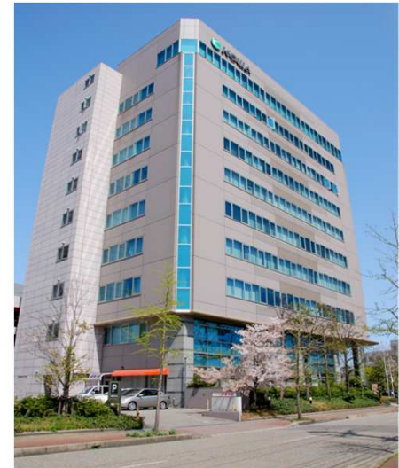
(2Fの執務室、応接室約262㎡に地中熱空調を導入。車両通路に100mの地中熱交換器を8本埋設。)
