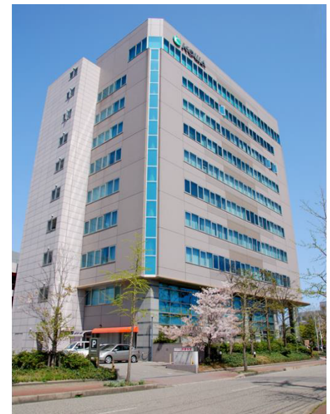
(2Fの執務室、応接室約262㎡に地中熱空調を導入。車両通路に100mの地中熱交換器を8本埋設。)
