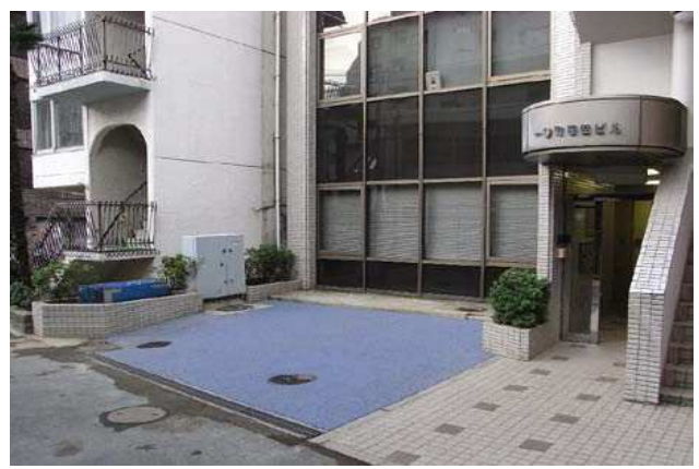
建物は1990年に竣工。車2台分の駐車場に75mの地中熱交換器を8本埋設。駐車場中央部には55mの温度観測孔がある。
