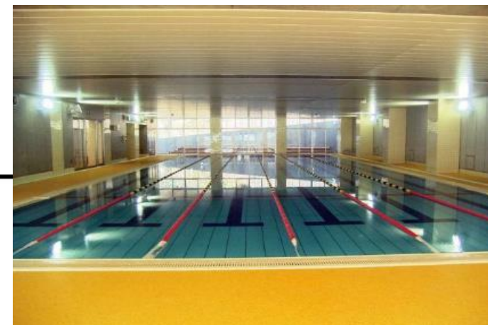
25m×6コース(水量337.5m³)の加温と室内の暖房を行う。
