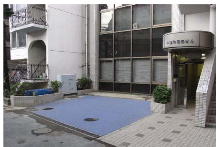
建物は1990年に竣工。車2台分の駐車場に75mの地中熱交換器を8本埋設。駐車場中央部には55mの温度観測孔がある。 [施設外観]
