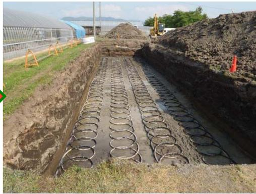
2. 熱交換器設置(下段, GL-2.0m)
