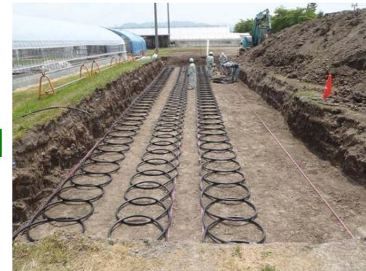
4. 熱交換器設置(上段, GL-1.0m)
