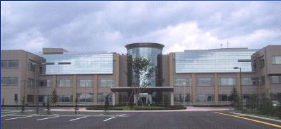
対象施設外観 (岩手県環境保健研究センター)
