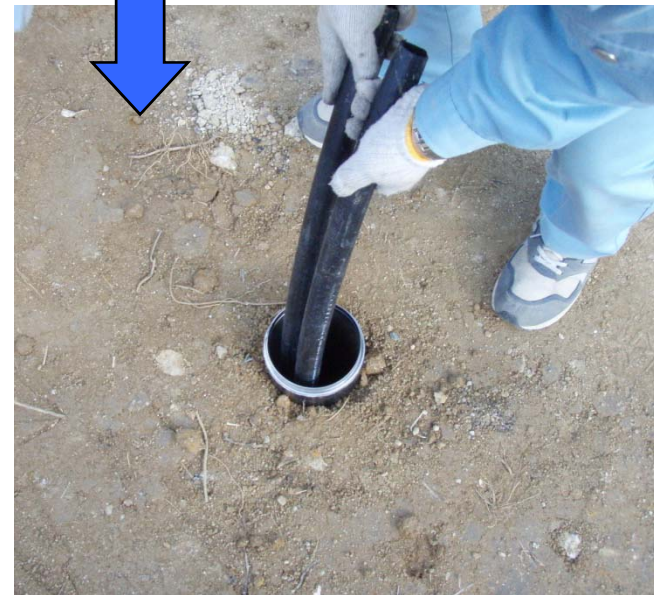
3. Uチュー ブの施工
