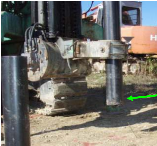
1. 鋼管杭 の施工 先端閉塞
