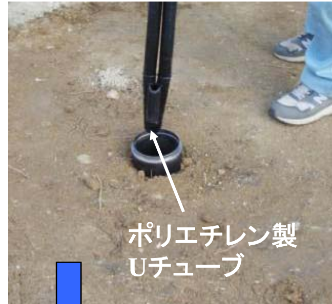
2. Uチュー ブの施工
