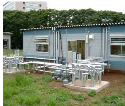
実験施設および杭上部配管状況
