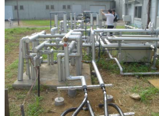
配管設置状況
