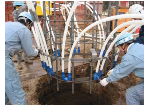
地中熱交換パイプ設置状況
