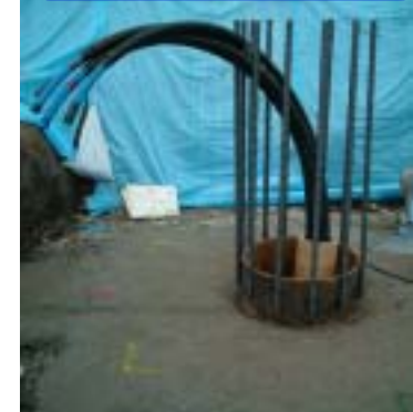
Uチューブ挿入後 の鋼管杭
