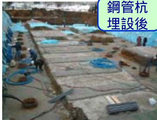
鋼管杭 埋設時
