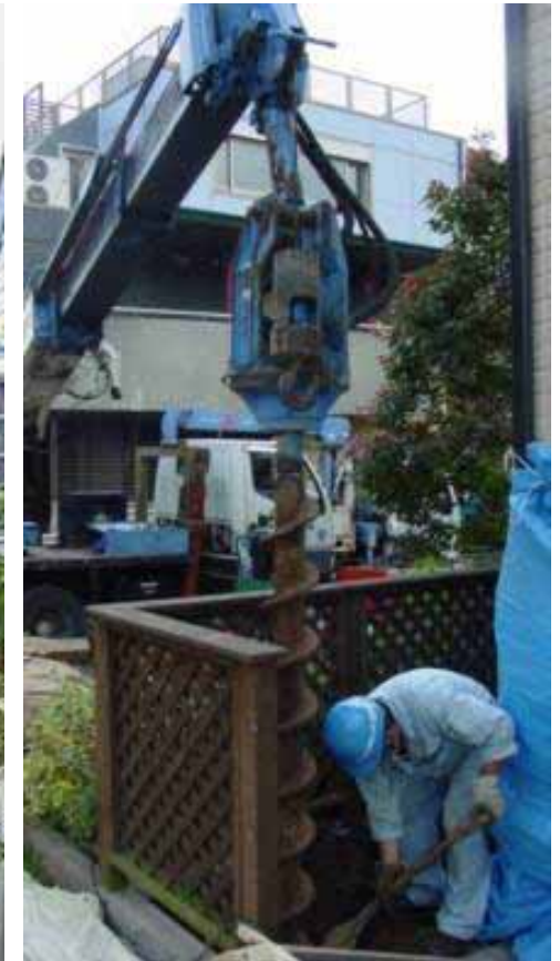
ロータリー工法 ボーリングより安価
