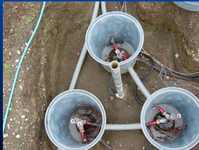
設置状況(群杭)
